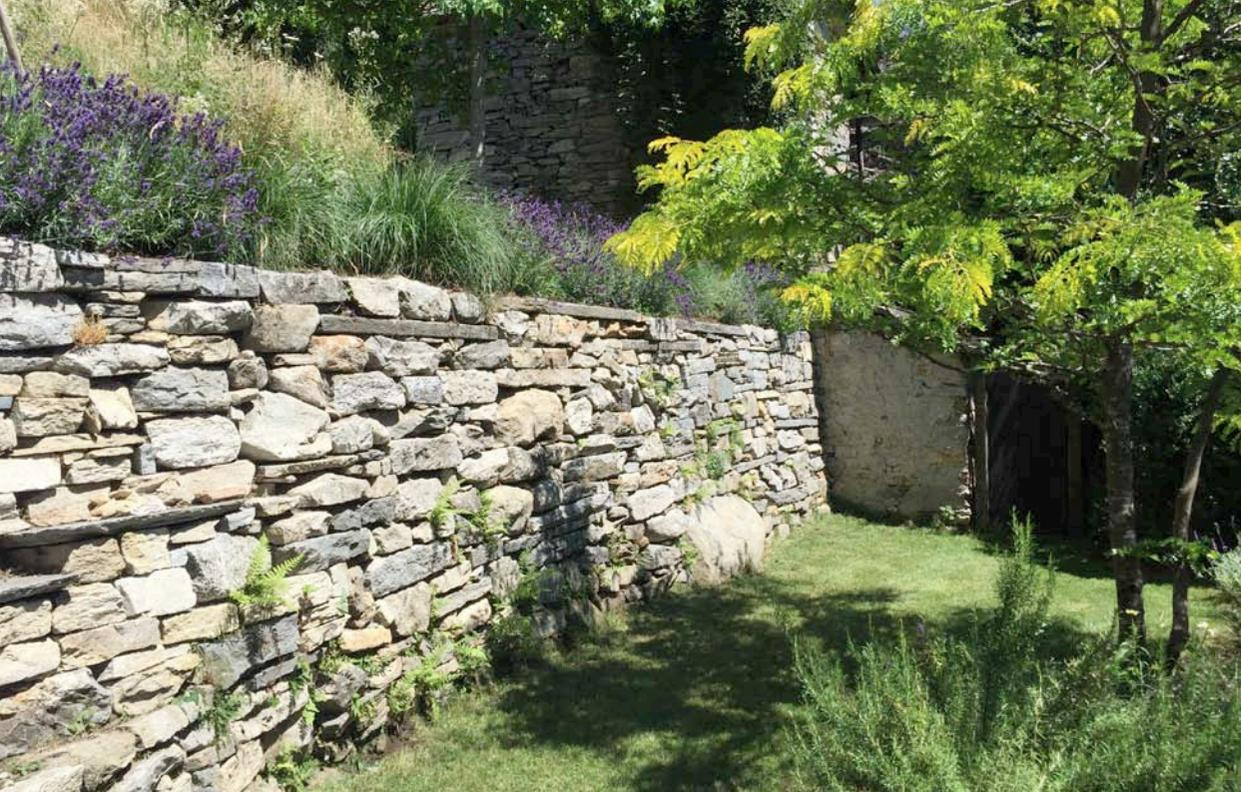
Sorgfältig: Wichtig für den Aufbau einer Trockenmauer ist, dass jeder Stein die Nachbarsteine berührt und die Hohlräume mit Schotter aufgefüllt werden.
