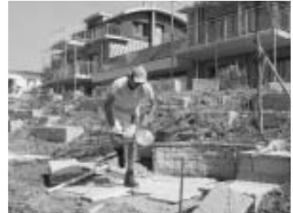
Der kleine Südsitzplatz entsteht.
