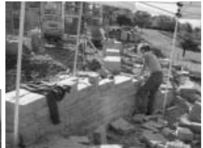
Die Trockenmauer nimmt Gestalt an.
