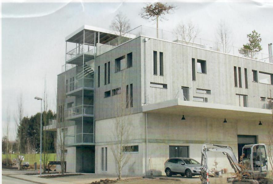
Das in kombinierter Bauweise aus Beton und Holz erstellte, modular aufgebaute Gebäude verfügt über eine grosszügige Werkhalle. Büro- und Wohnräume stehen zur Vermietung. Der Dachgarten wird als Eventlokalisierung genutzt.
